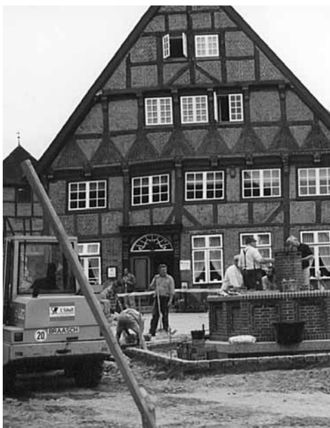
Der Brunnen während der Bauphase.
